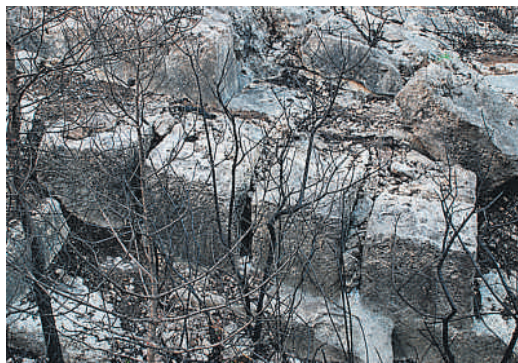
El treball d'extracció de cinc grans carreus al descobert
